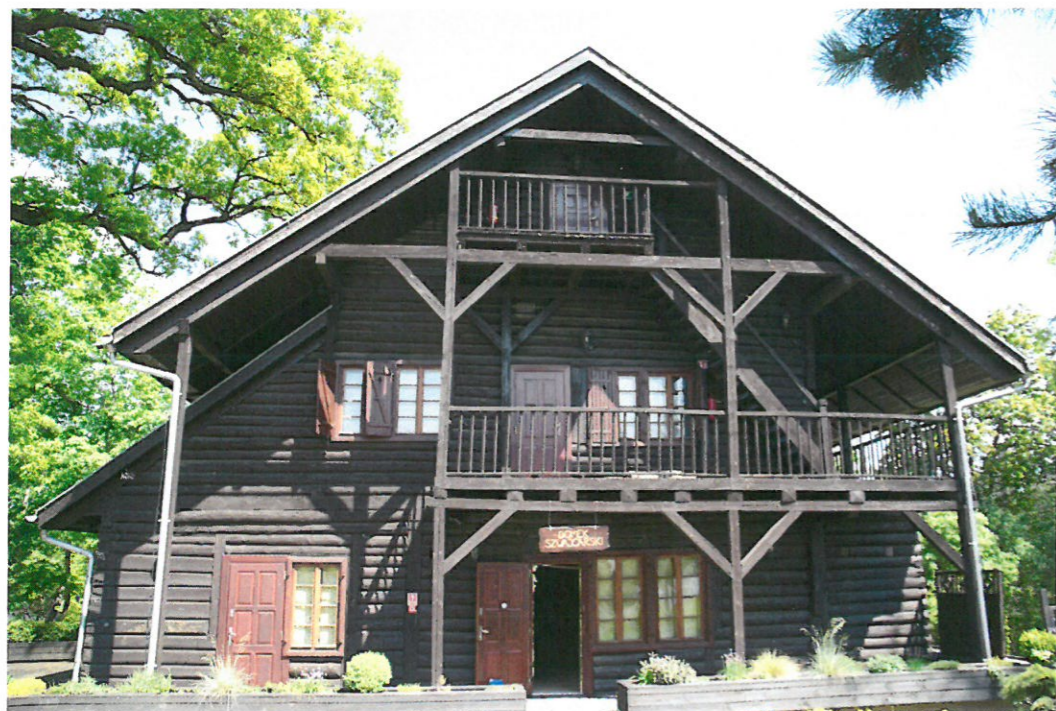
FOT. 1. ELEWACJA POŁUDNIOWO – ZACHODNIA
