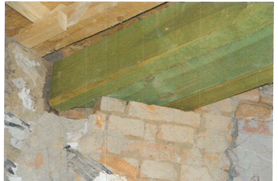
Brak oparcia belek Poz. 5 zgodnego z projektem, tj min. 210 mm. Fot. Olgierd Pietrzak, maj 2020 r.
