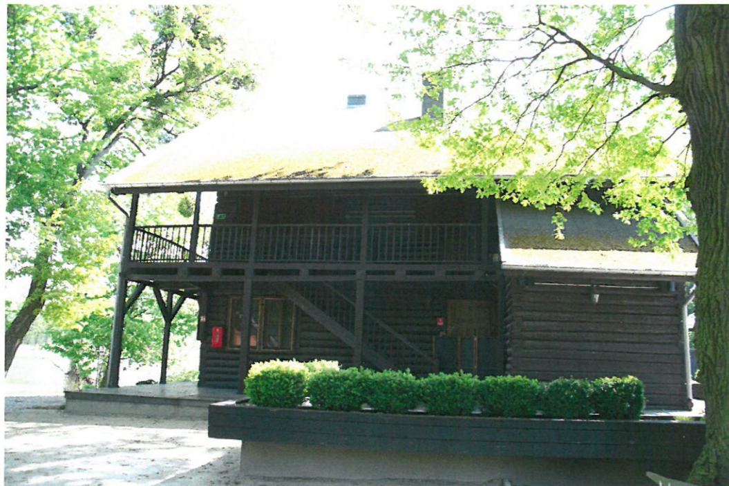
FOT. 2. ELEWACJA PÓŁNOCNO – ZACHODNIA
