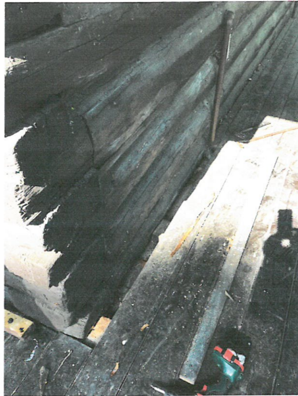
Podwalina północnej ściany wieńcowej zakryta płytą tarasu. Widoczna odkrywka podwaliny. Fot. Olgierd Pietrzak, maj 2020 r.
