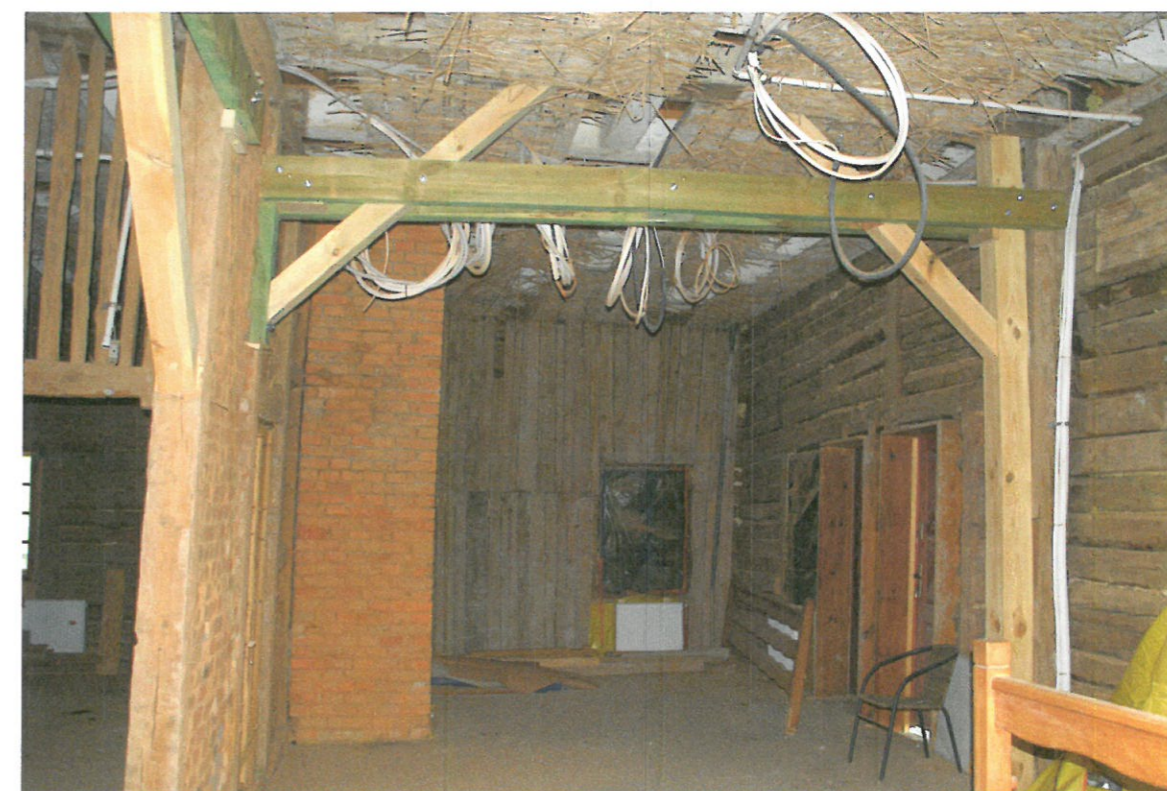
Ściana wewnętrzna piętra Poz. 11 wykonana niezgodnie z projektem jako odbicie lustrzane. Fot. Olgierd Pietrzak, maj 2020 r.
