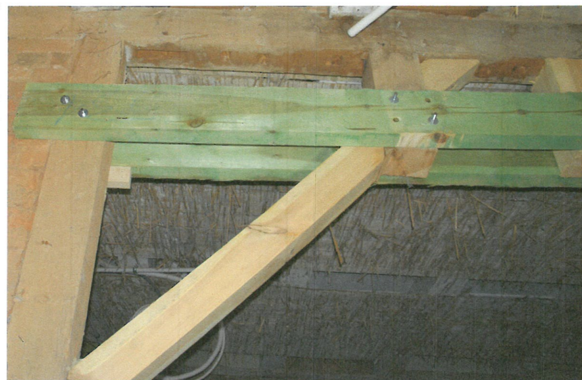
Ściana wewnętrzna piętra Poz. 10. Szczegół „styk A” i „styk B”. Fot. Olgierd Pietrzak, maj 2020 r.
