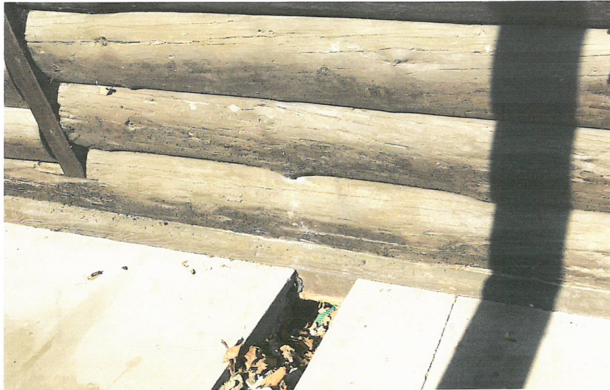
Podwalina wschodniej ściany wieńcowej zakryta betonową płytą tarasu. Widoczna odkrywka podwaliny. Fot. Olgierd Pietrzak, maj 2020 r.
