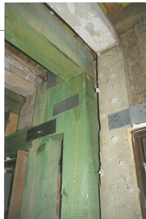
Ściana wewnętrzna parteru Poz. 6 po pracach „naprawczych”. Wykonanie niezgodne z projektem. Fot. Olgierd Pietrzak, maj 2020 r.
