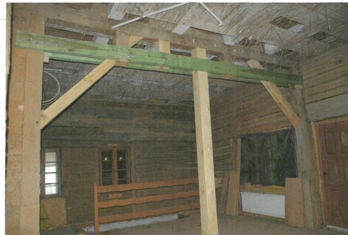
Ściana wewnętrzna piętra Poz. 10 po przebudowie. Wykonanie niezgodne z projektem. Fot. Olgierd Pietrzak, maj 2020 r.
