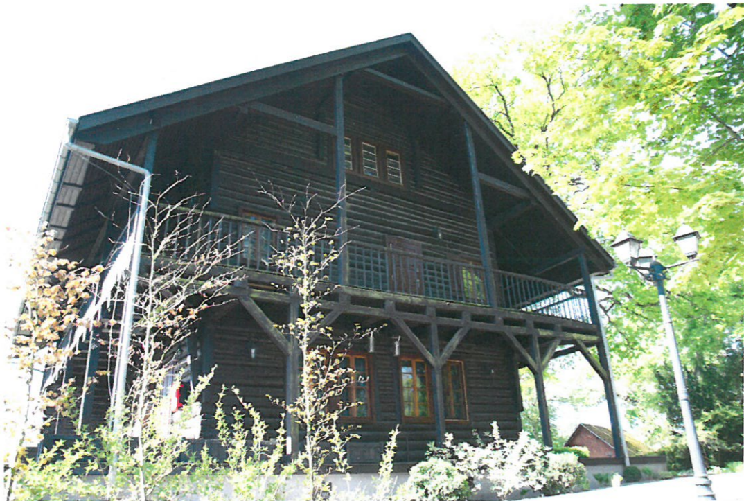
FOT. 3. ELEWACJA PÓŁNOCNO - WSCHODNIA
