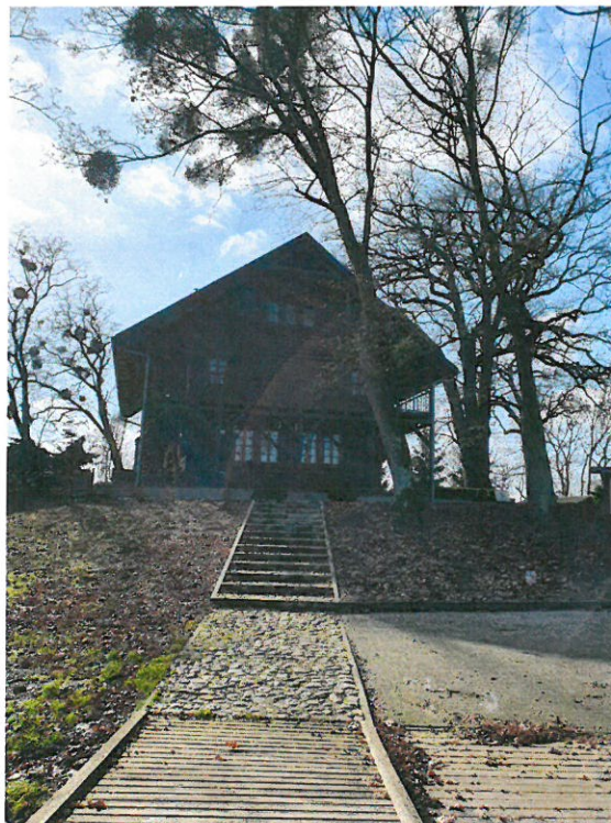
Istniejące utwardzenie z kamienia polnego
