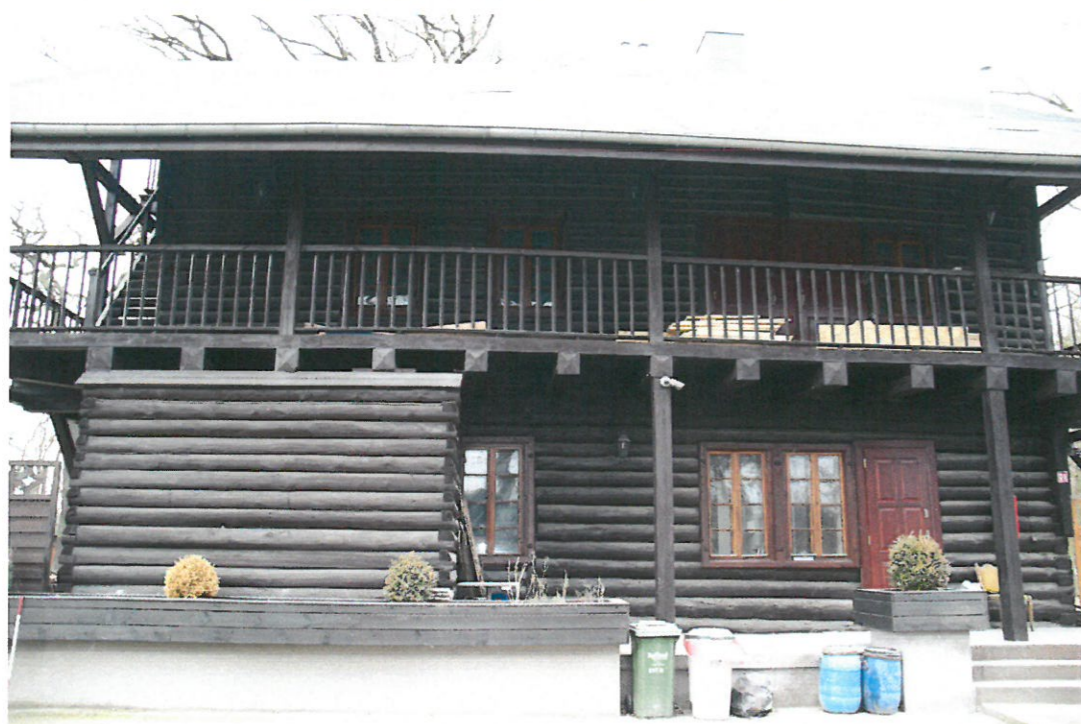
FOT. 4. ELEWACJA POŁUDNIOWO - WSCHODNIA
