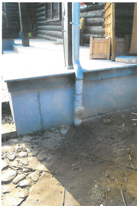
Taras od strony północnej. Odprowadzenie wody opadowej. Fot. Olgierd Pietrzak, luty 2018 r.
